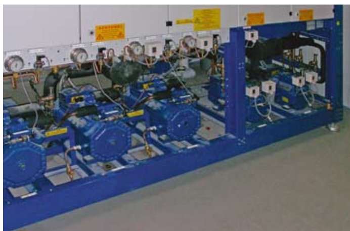
Bild 3: Verdichter
