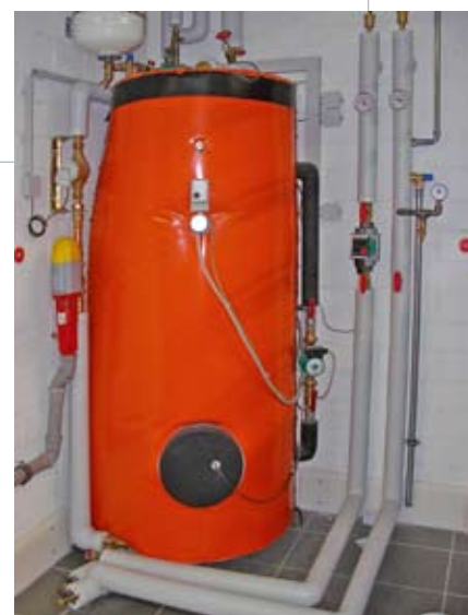
Bild 7: Wärmespeicher
