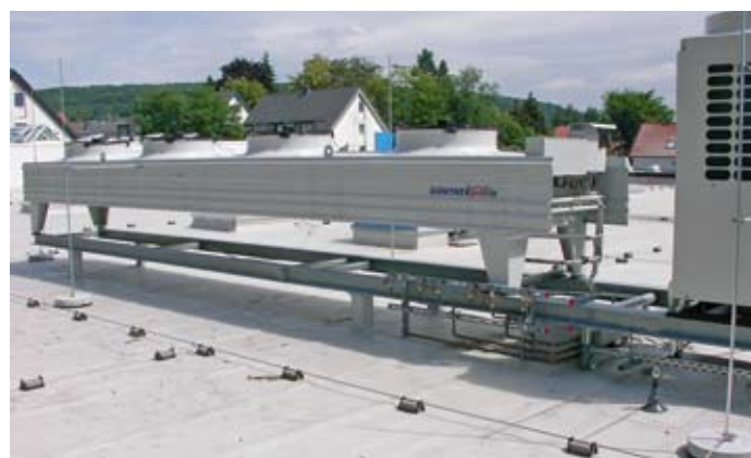
Bild 8: Außenkühler
