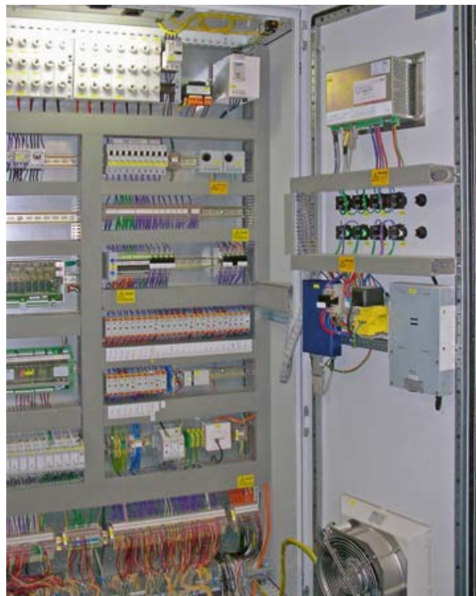
Bild 5: Schaltschrank für die Kälteanlage und die Gebäudeleittechnik
